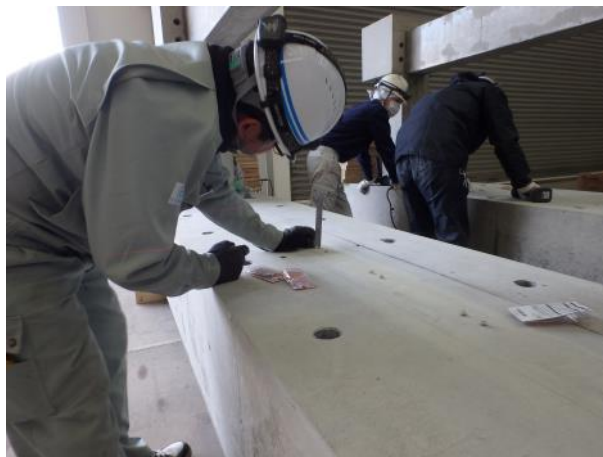
図 4.2.2-2 スペーサー設置状況 (レーザーレベルを用いて調整)
