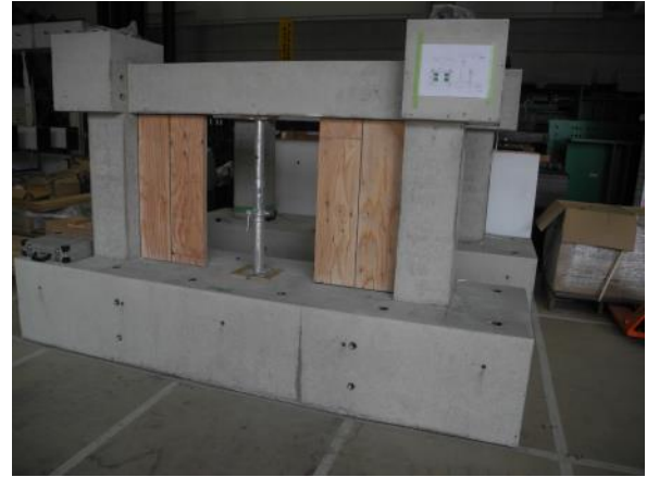
図 4.2.2-15 施工完了状況 (袖壁試験体)
