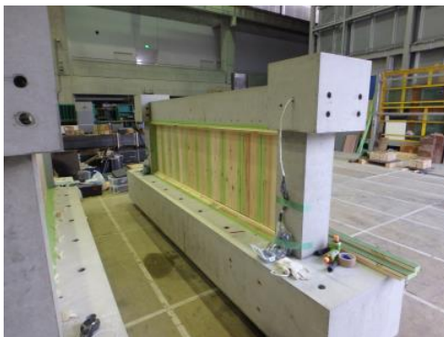
図 4.2.3-1 パネル支持材を省略したパネルの建て方
