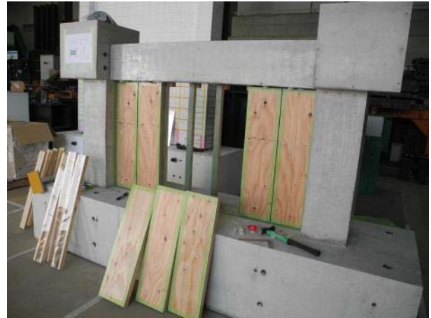
図 4.2.2-6 LVL パネルの建て方
