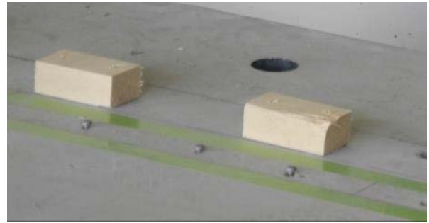
図 4.2.2-4 型枠支持材とスペーサー
