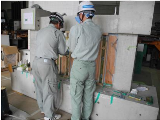
図 4.2.2-9 接着剤充填状況
