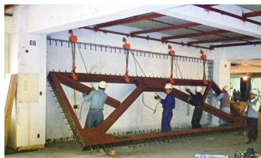
鉄骨ブレース増設
