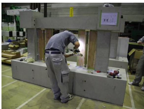
図 4.2.2-7 型枠施工状況 (剥離シート打設状況)
