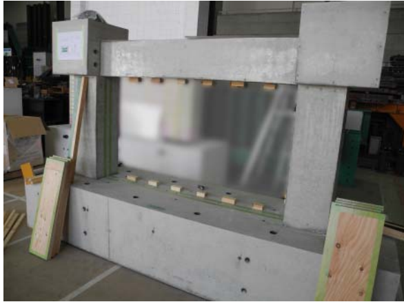
図 4.2.2-3 型枠支持材施工状況
