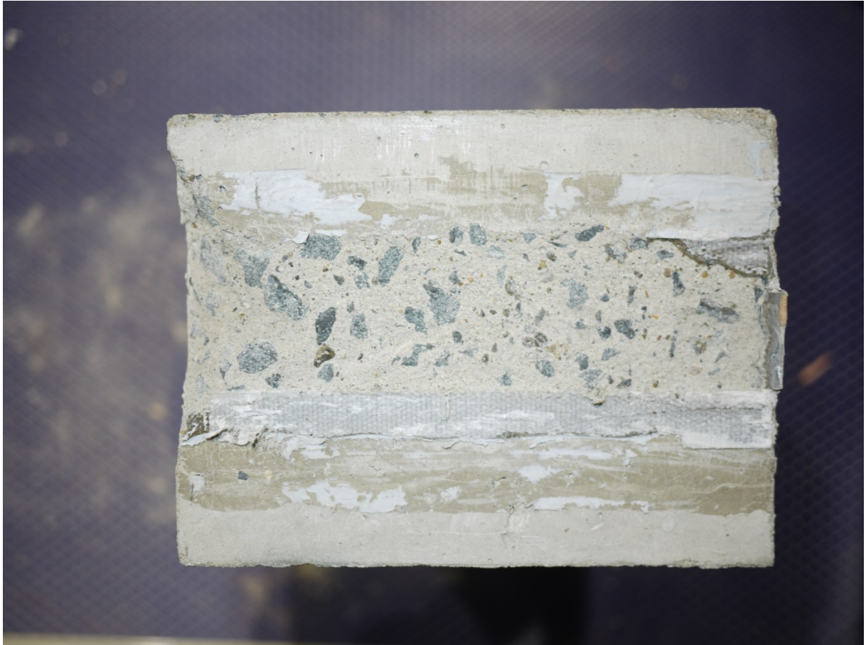
図 5.1.5-7 コンクリートの破壊状況
