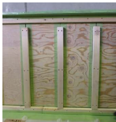
図 4.2.3-3 型枠材の取付 (パネルに直接ビス止め)
