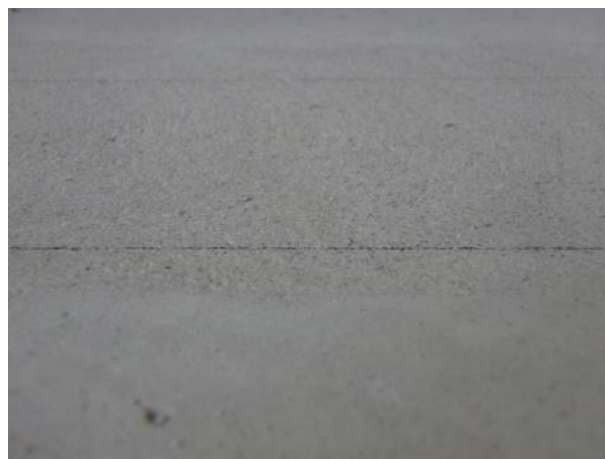
図 4.2.2-1 サンダー掛け後のコンクリート表面
