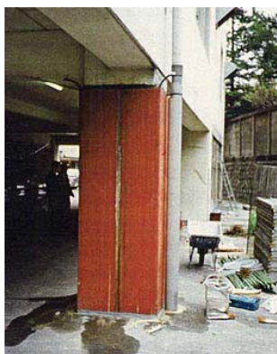
鋼板巻き補強
