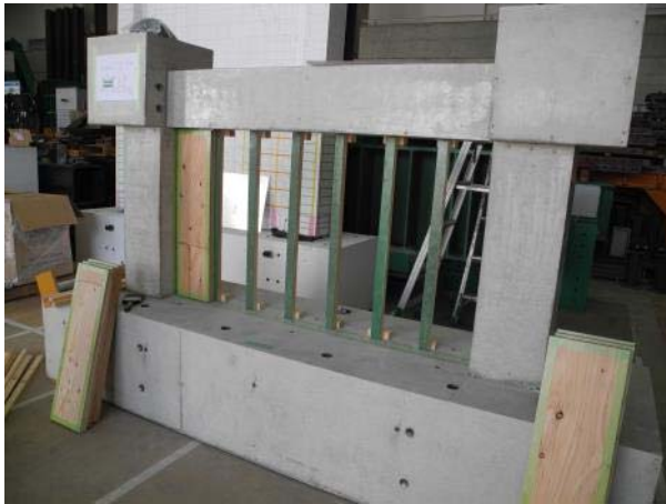
図 4.2.2-5 型枠兼用パネル支持材の設置
